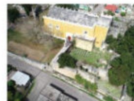
Iglesia de Tihosuco Latitud y Longitud: 20.195905 -88.373169
